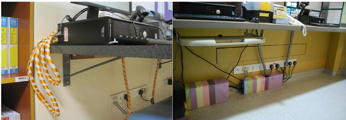
Susunan wayar komputer dikemaskan agar tidak berselirat dan lebih selamat
